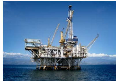
Ingersoll Rand 壓縮機與幫浦 用於石油與天然氣探勘。
